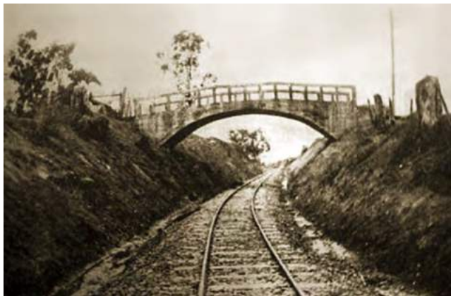
Puente carretero sobre la vía férrea, Idahue.
