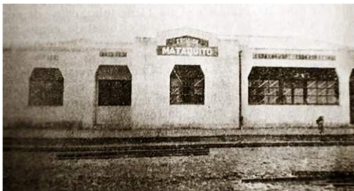
Estación Mataquito durante la construcción de la vía.
