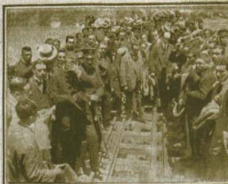
En el acto de ser inaugurado el puente del Maule, en el ferrocarril de Talca a Constitución, por el Ministro de Industria y Obras Públicas, el domingo último.
