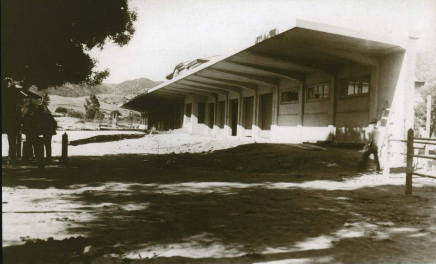
Cubierta de andén en la Estación de Constitución, año 1957.
